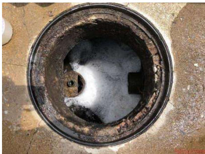
บ่อพักน้ำก่อนผ่านระบบบำบัดน้ำเสียอาคารที่พักผู้โดยสาร ขาออก
