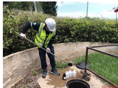
บ่อพักน้ำก่อนผ่านระบบบำบัดน้ำเสียอาคารที่พักผู้โดยสาร ขาออก
